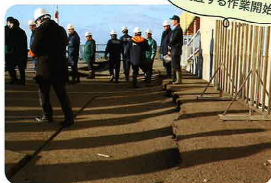
直江津港のふ頭でクラックが発生 地盤が軟弱で空洞ができてきている可能性もあり
